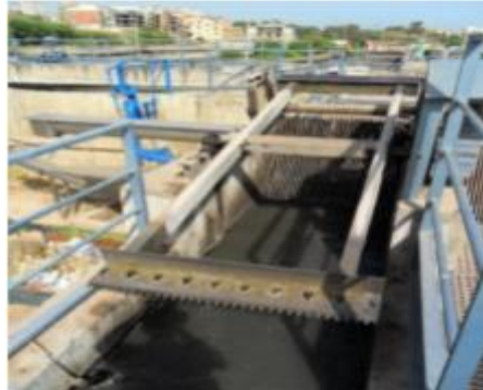
Figure 1.1 : Un dégrilleur [16].
