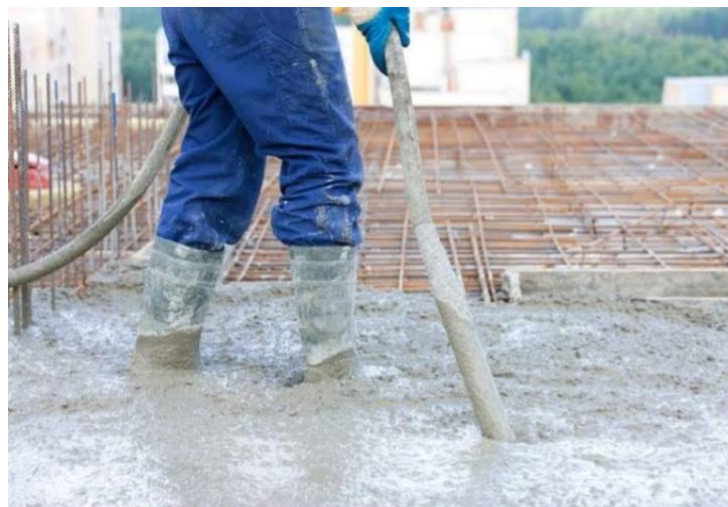
Figure 2-1 : Exemple d'un coulage d'une dalle en béton autoplaçant.
