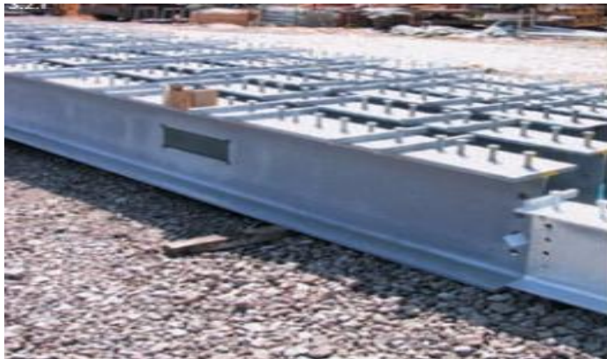
Figure VI.13: Poutre mixte avec goujons soudés avant la mise en œuvre.
