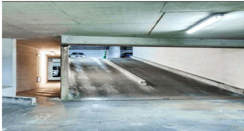
Figure VI.6 : demi-rampes séparées pour entrée et sortie
