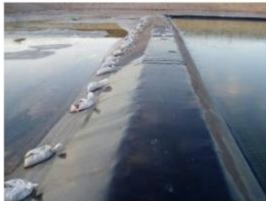
Figure 3.13: Utilisation pour Étanchéité.
