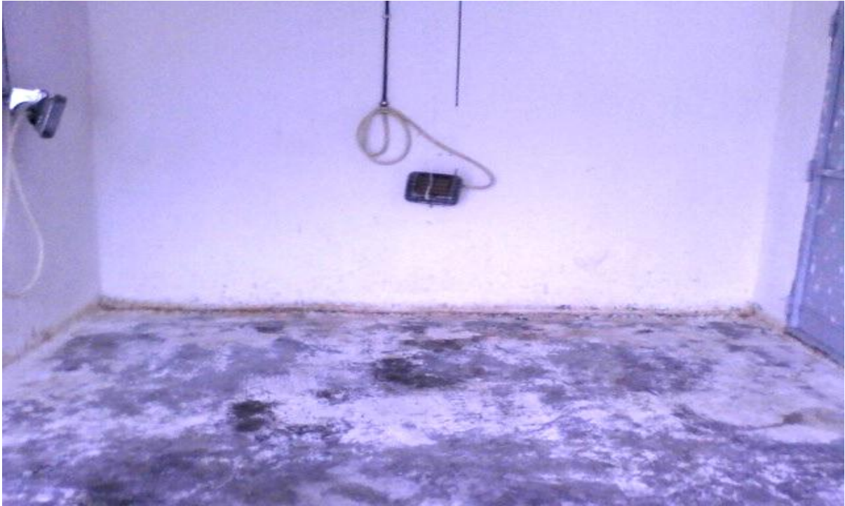
Fig 1 : Le bâtiment d'élevage en cours de la préparation
