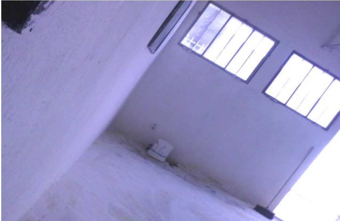
Fig 7 : Les moyens d'aération dans le bâtiment d'élevage
