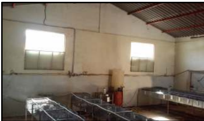
Photo 03 : Ventilation statique à l'intérieur du bâtiment
