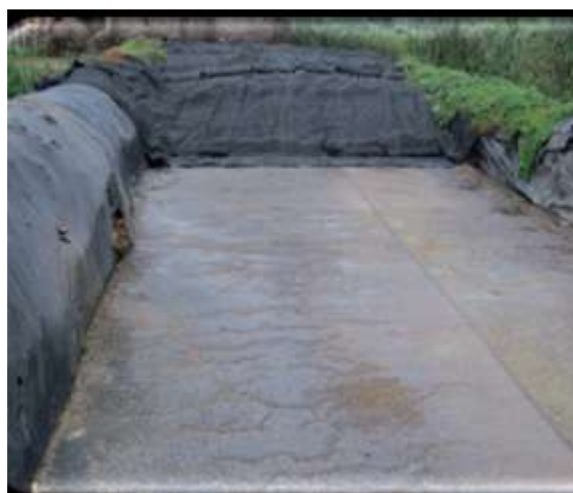
Photo 7 : Silo couloir avec plateforme bétonnée (IKARE, 2015)
