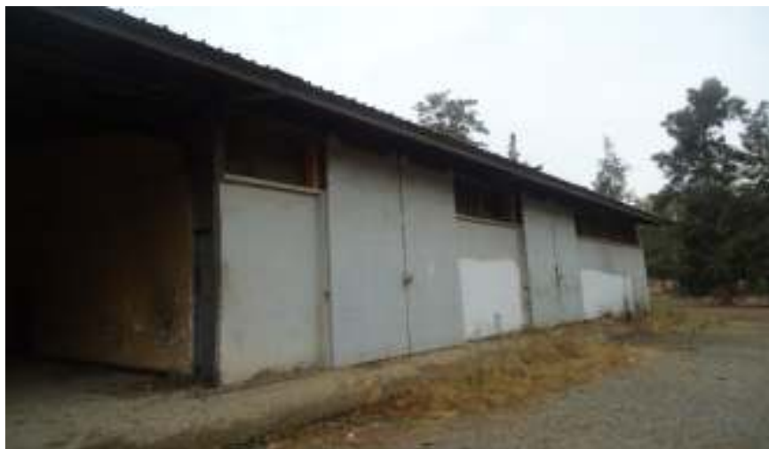
Figure 17 : Bâtiment 9 (atelier agricole)
