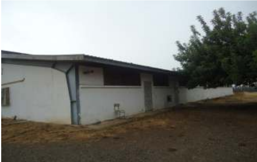
Figure 6 : Bâtiment 2 (bergerie + chèvrerie)
