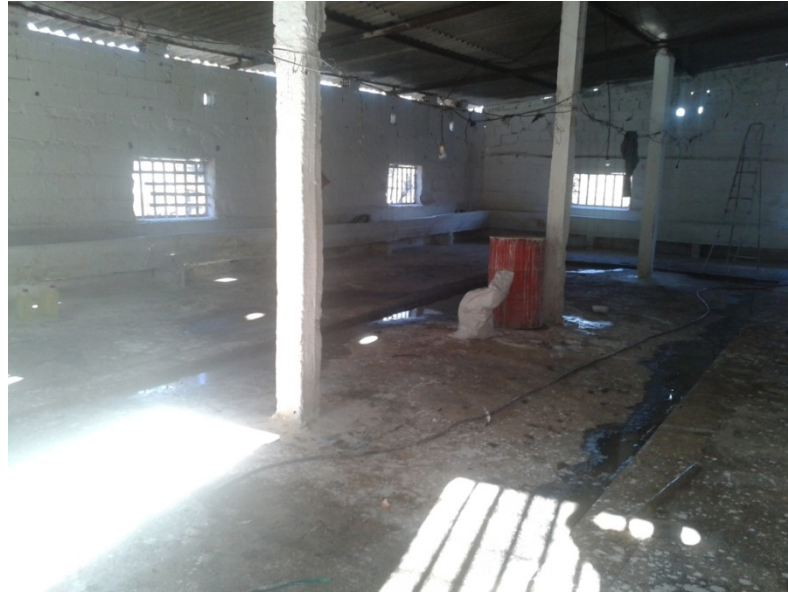
Photo 02: préparation du bâtiment avant la mise en place.
