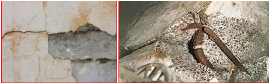
Figure I.3 : Dégradations du béton dû à la réaction alcalis-granulats
