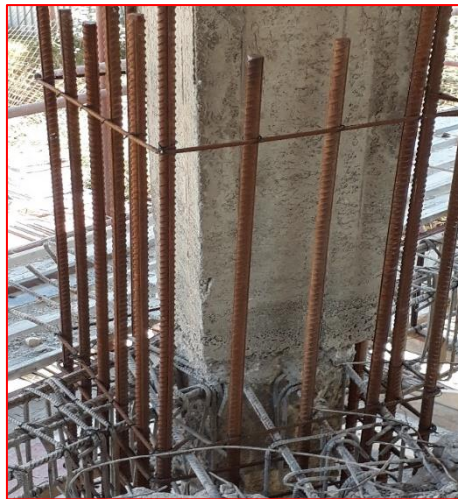
Figure IV.10 : Poutre décalée du poteau
