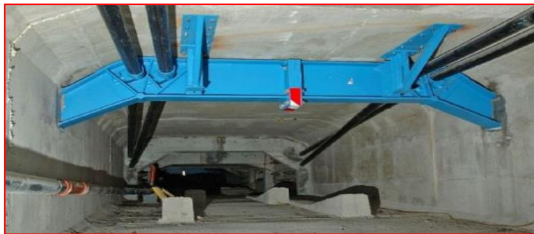
Figure I.28 : technique de précontrainte additionnelle
