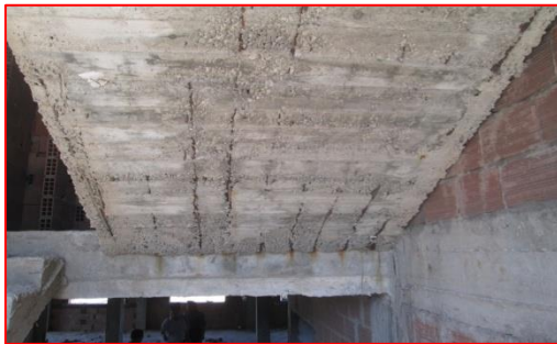
Figure IV.11 : Ségrégation avec corrosion des armatures
