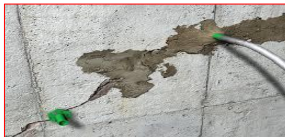
Figure I.24 : Méthode d'injection
