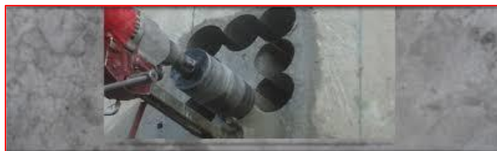
Figure I.18 : Prélèvement de carottes
