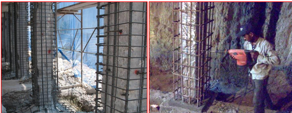
Figure I.23 : mise en place des armatures de renforcement avec augmentation de la rugosité du poteau
