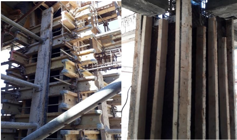
Figure IV.17 : Réalisation du coffrage des poteaux à chemiser
