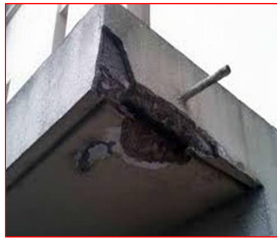
Figure I.13 : Epaufrures causées par le choc dans la construction
