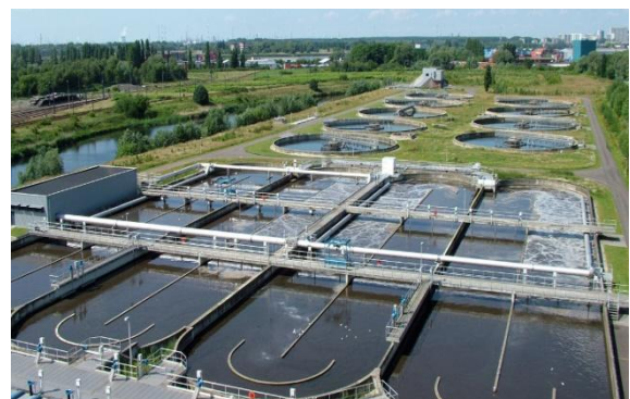
Fig 90 : Station d'épuration des eaux usées. Source : Google image.
