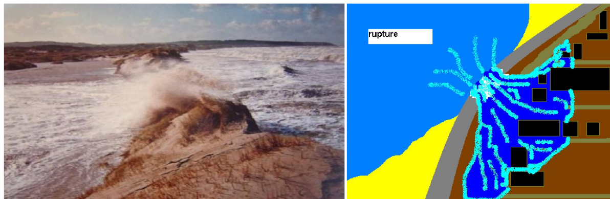
Figure 52: Exemple de rupture du cordon dunaire, avec schéma.
