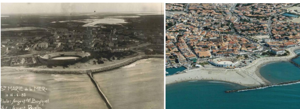
Figure 47: Le front de mer des Saintes-Mairies-de-la-Mer, France, en 1932 (à gauche) et en 2009 (à droite). Source: Mairie des Saintes.
