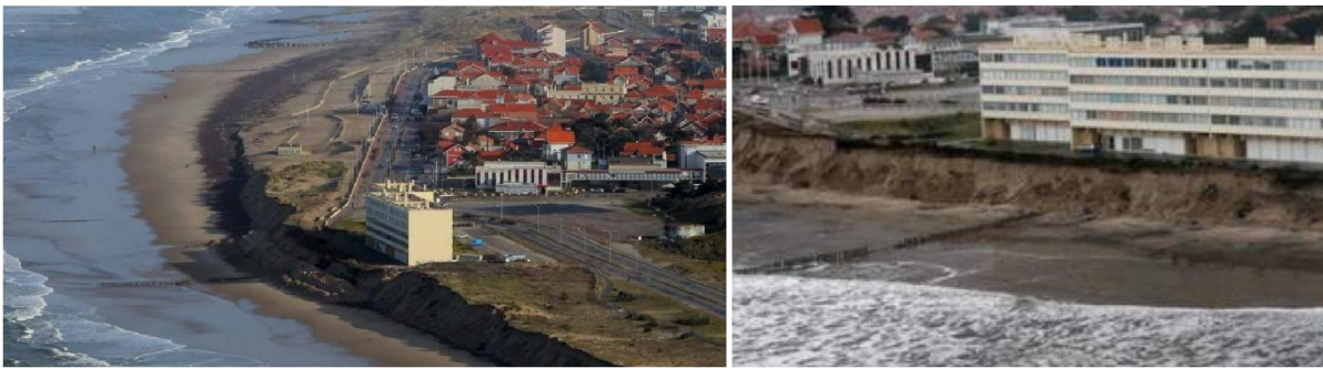
Figure 46: L'immeuble Le Signal en janvier 2014, Soulac sur mer, France. Source: Youtube
