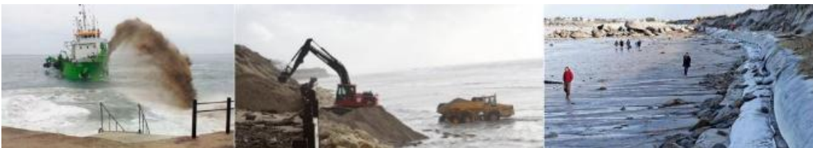
Figure 62: Ré ensablement par bateau
