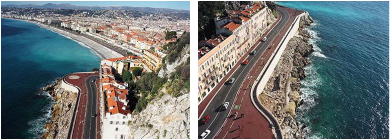
Figure 11 : Requalification de RaubaCapeu - Ville de Nice - France. Source: thèse/ La vue sur mer et l'urbanisation du littoral.
