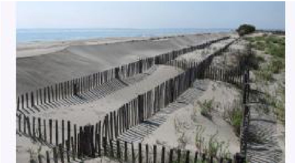
Figure 49: Photo des Ganivelles utilisées pour la protection des plages de l'érosion
