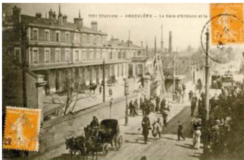
Figure 03 : L'ancienne passerelle « Chaignaud » de franchissement des voies ferrées.
