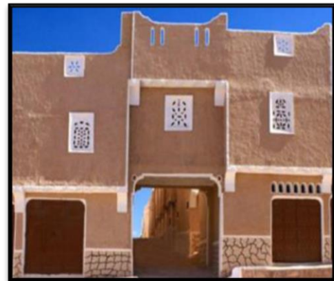
Figure 11 : Façade du ksar Tafilet.
