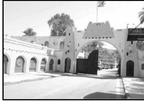
Figure 73: entrée principale dans Ghardaïa Source : Google image
