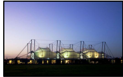
Figure 23 : centre de recherche de Schlumberger. Source : google image
