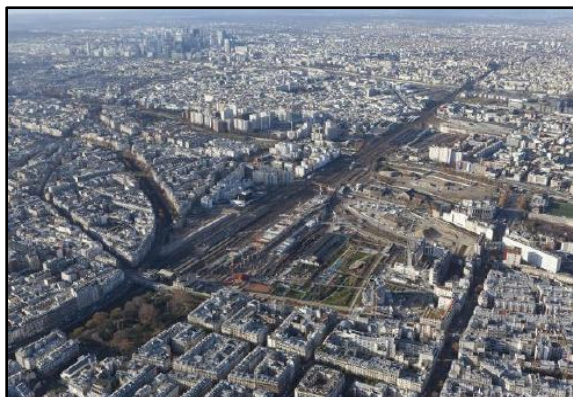
Figure 2-8 : projet urbain de Clichy, début de travaux
