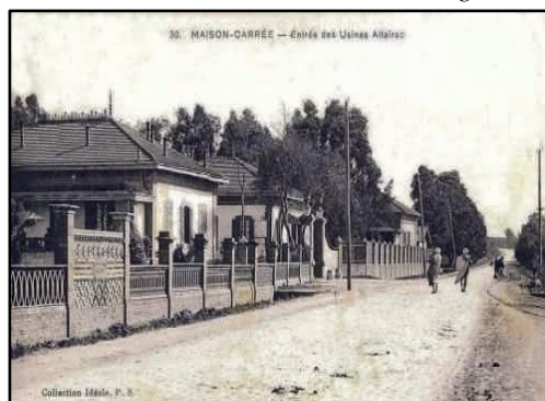
Figure3-19 : unité industrielle source : judaicalgeria.com
