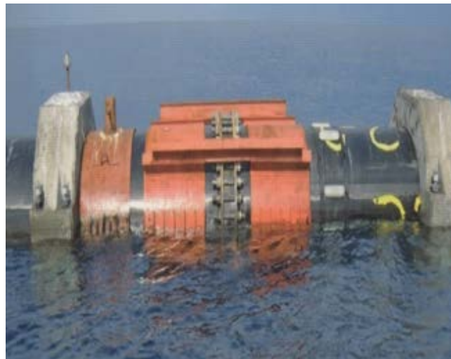
Figure 3.6: Émissaire submersible [22].
