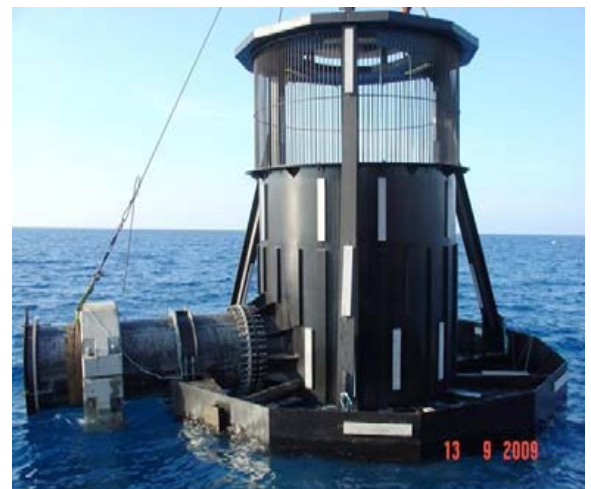
Figure 3.4: Tête de prise d'eau [22].
