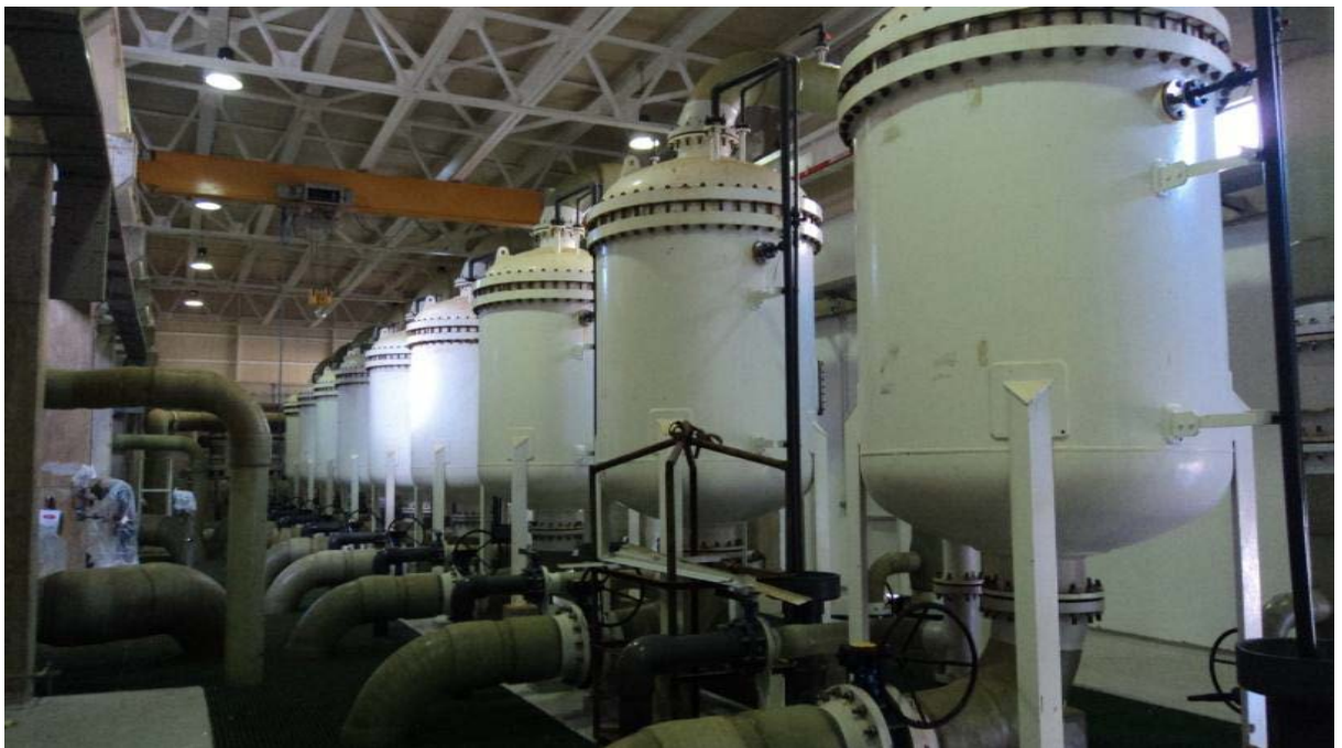
Figure 3.9: L'unité des filtres à cartouches
