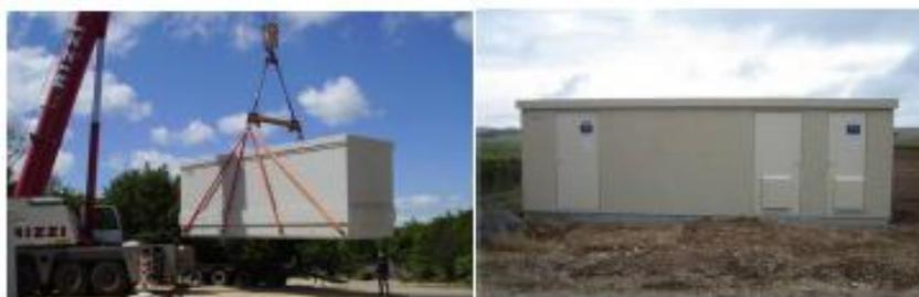
*Figure I.6 : Installation d'un poste électrique (Source EOLE-RES)*
