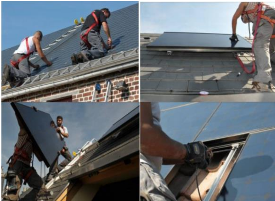
Figure (II-12): Installation des modules en toiture
