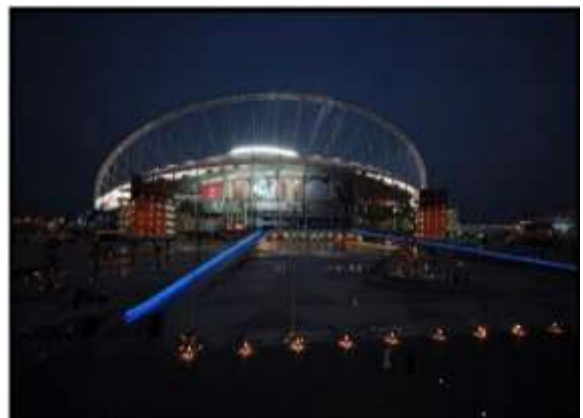
Figure (2.25) : vue sur l'accès du stade
