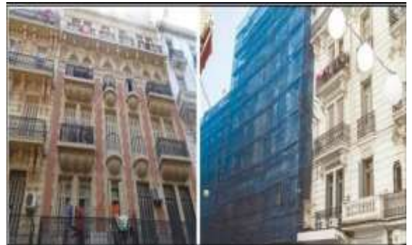
Figure (2.3) : réhabilitation d'une façade
