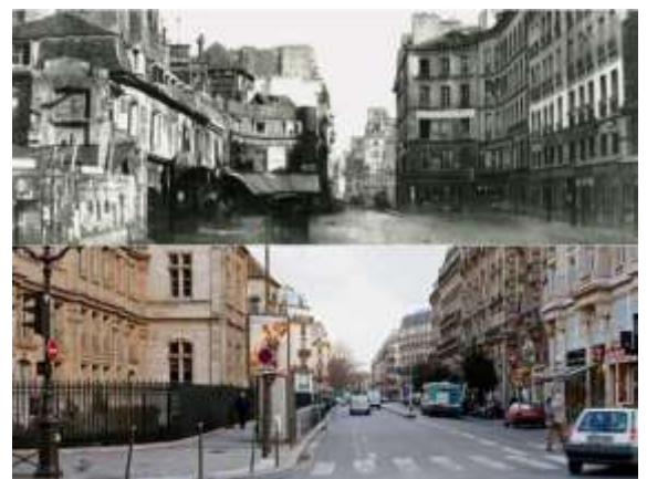
Figure (2.7) : requalification « rue Réaumur France »
