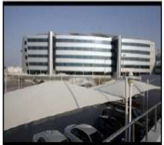
Figure (2.34) : vue sur le bloc d'hébergement
