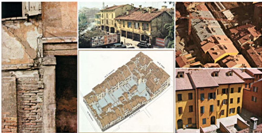
Figure 2.7 : BOLOGNA, Restauration du quartier San Leonardo
