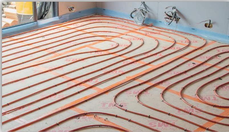
Figure 2- 2 : Le plancher chauffant [10].
