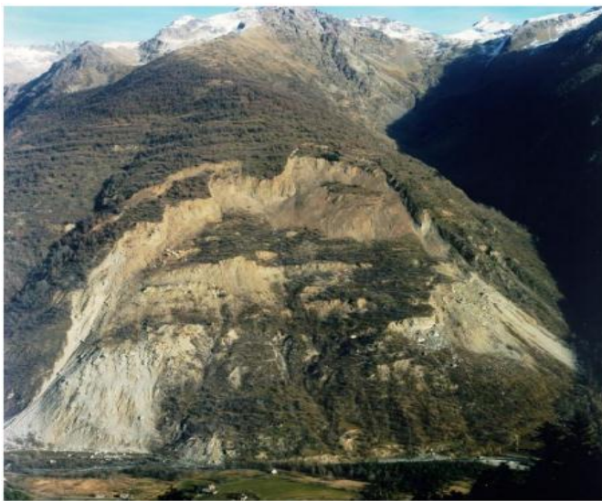
Cas (1) : La Clapière, le plus grand glissement de terrain d'Europe (1100 m de long 750 m de haut, 50 millions m 3 ), image [3]
