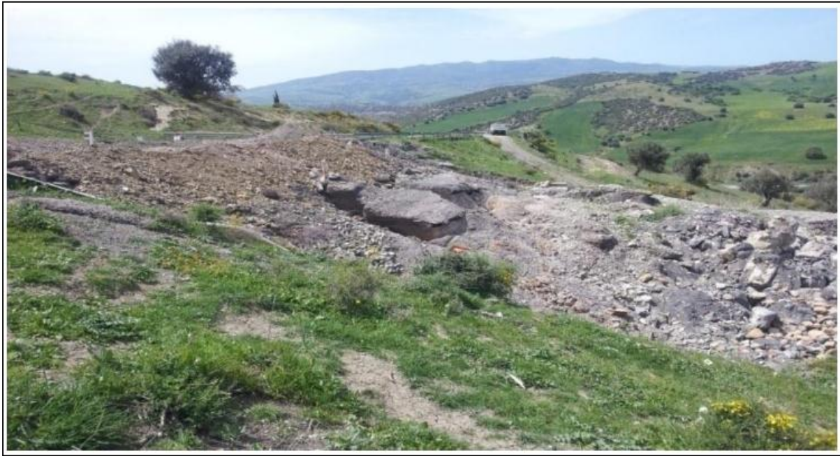
Figure 1.17 : Une vue d'ensemble de l'étendu du glissement [1]
