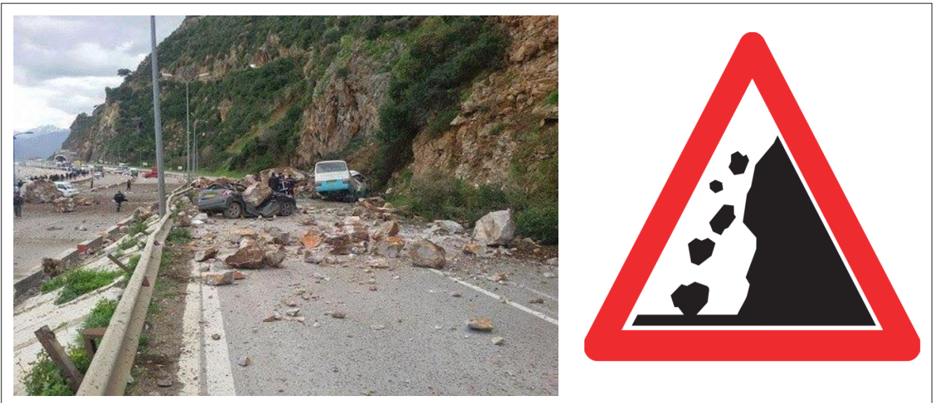
Figure 1.3 : Éboulement on chute de pierre à hauteur du tunnel éponyme sur le RN26 reliant Bejaia à Sétif. [7]
