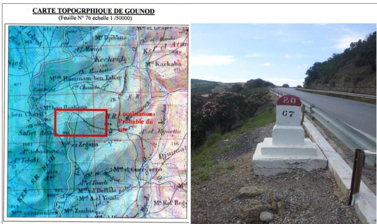
Figure 1.16 : Localisation du point de glissement sur la RN80 Pk67+500 [1]
