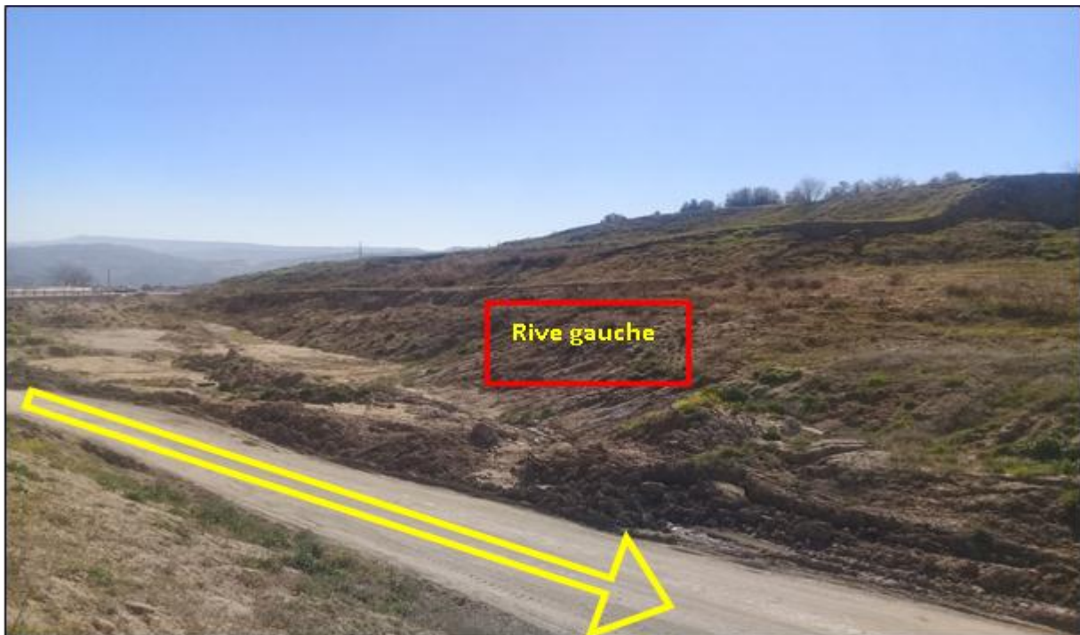
Figure II.6 : Vue générale du glissement. [24]
