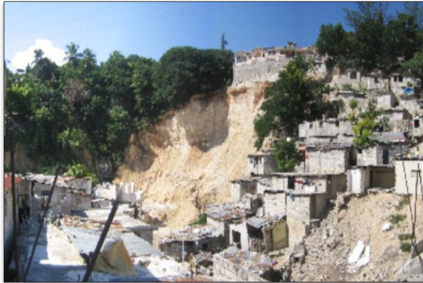
Figure 1.14 : Le glissement de terrain à l'impasse Avalon Musseau [20]
