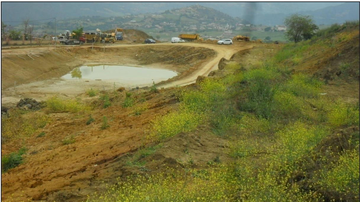
Figure II.10 : Accumulations des eaux pluviales au niveau de la chaussée. [24]
