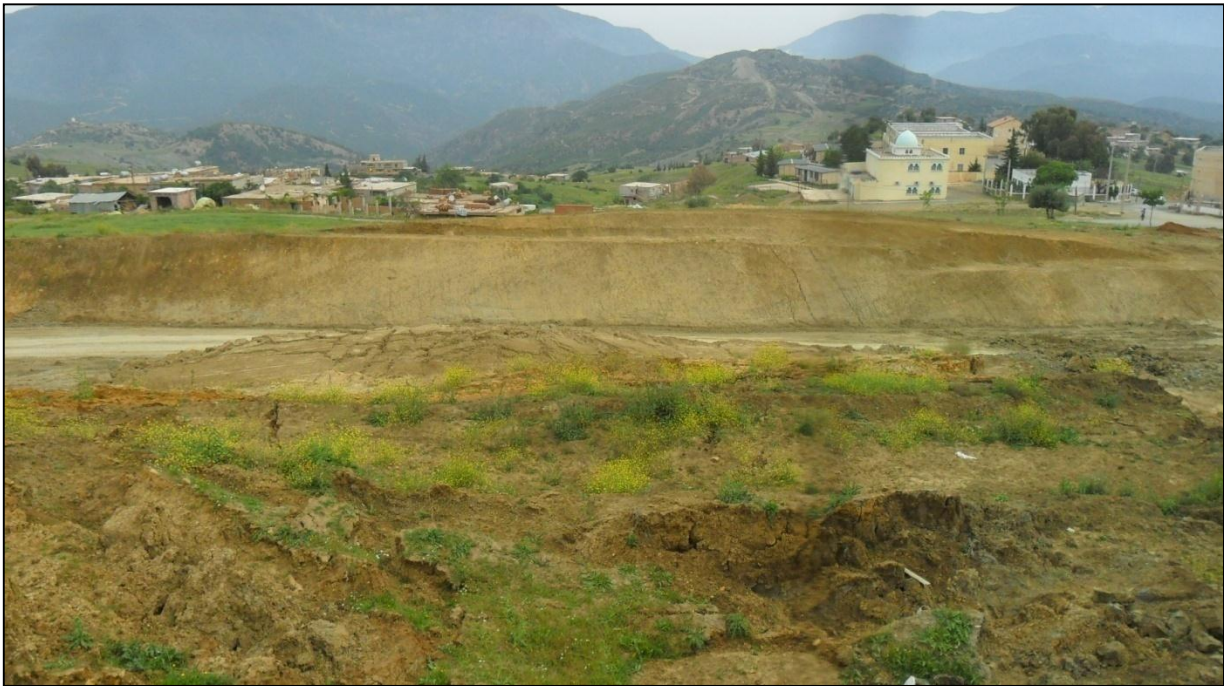
Figure II.13 : Aucun signe d’instabilité apparent au niveau du talus de déblai de la rive droite. [24]
