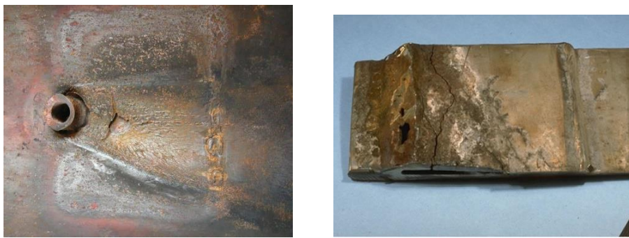
Figure 3.5. Corrosion sous contrainte.
