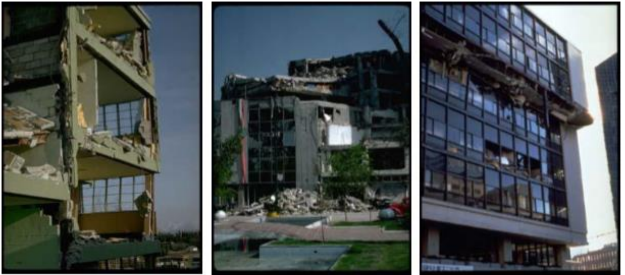
Désolidarisation des façades, destruction des étages
