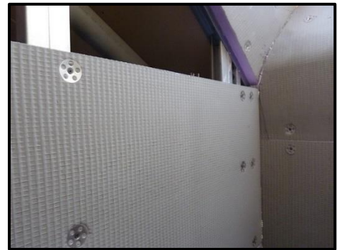
Figure 218 : Panneau à visser (Source : http://detailsconstructifs.cype.fr/ )
