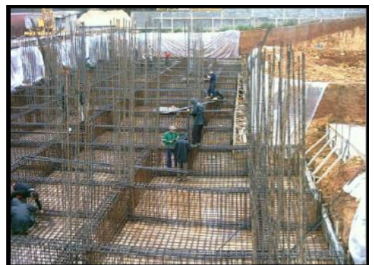
Figure 141 : Fondation en radier ( Source : https://www.be-gph.fr/blog/115-le-radier-un-systeme-de-fondation-avec-beaucoup-de-prejuges.html )
