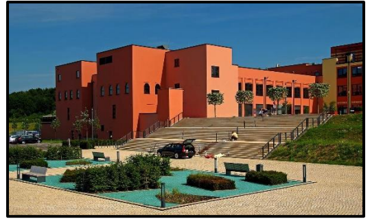
Figure 61: L'extérieur de projet (Source : Mémoire de fin d'étude, conception d'un complexe thermique à Sidi Abdelli, 2016 )
