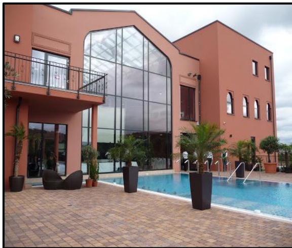
Figure 64 : L'extérieur de projet (Source : Mémoire de fin d'étude, conception d'un complexe thermique à Sidi Abdelli, 2016 )
