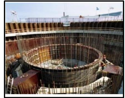
Figure 143 : Voile périphérique (Source : http://imagesdubtp.iutrs.unistra.fr/ )
