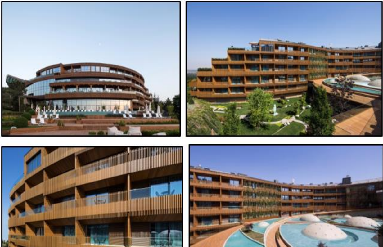
Figure 54 : L'extérieur de projet ( Source : https://www.gadarchitecture.com/en/eskisehir-spa--thermal-hotel )
