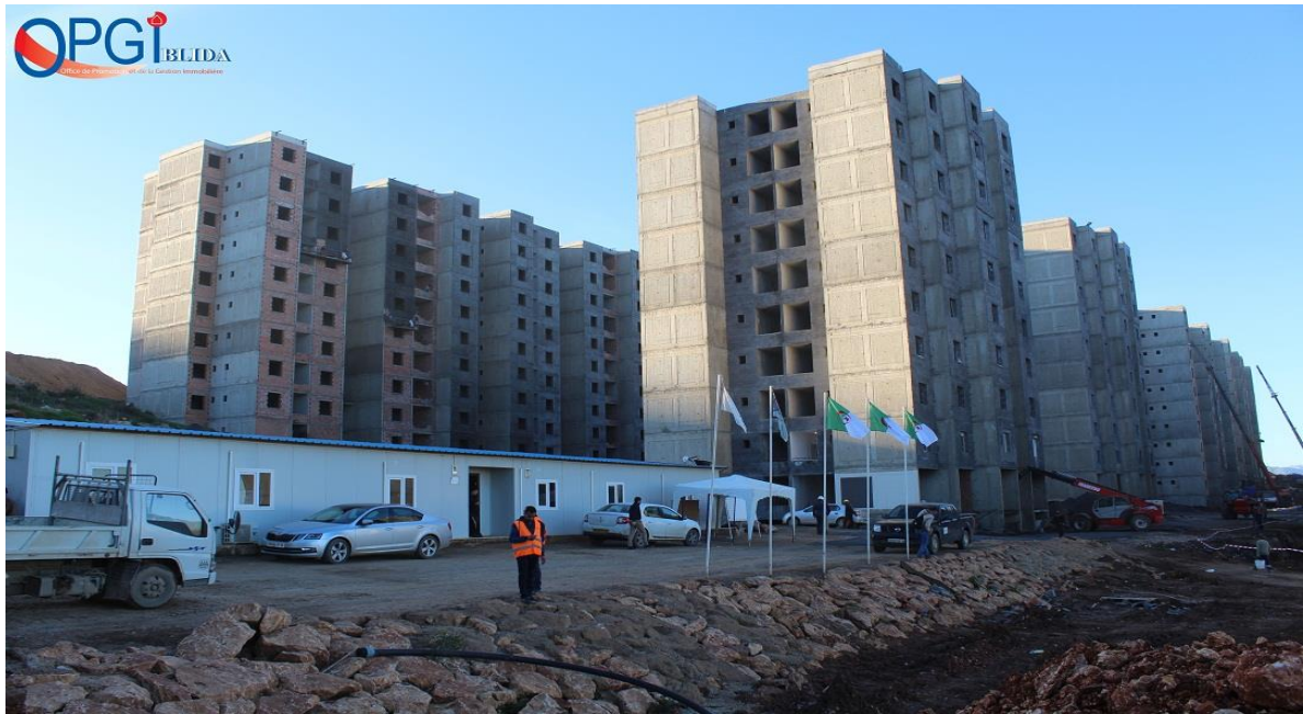
Figure I.4 : Déroulement des travaux sur le projet (Source OPGI BLIDA)
