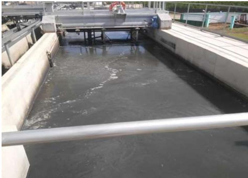
**Figure 04** : Ouvrage de dessablage /désuilage
