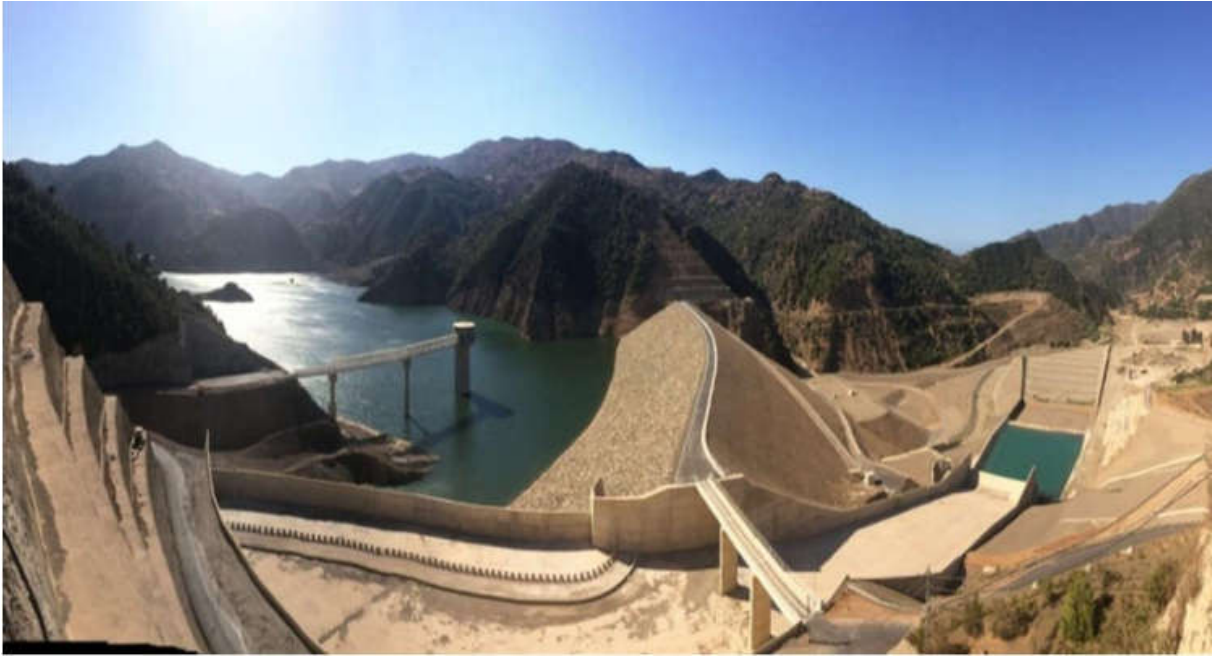
Figure 03: Vue générale du barrage Kef Eddir [3].
