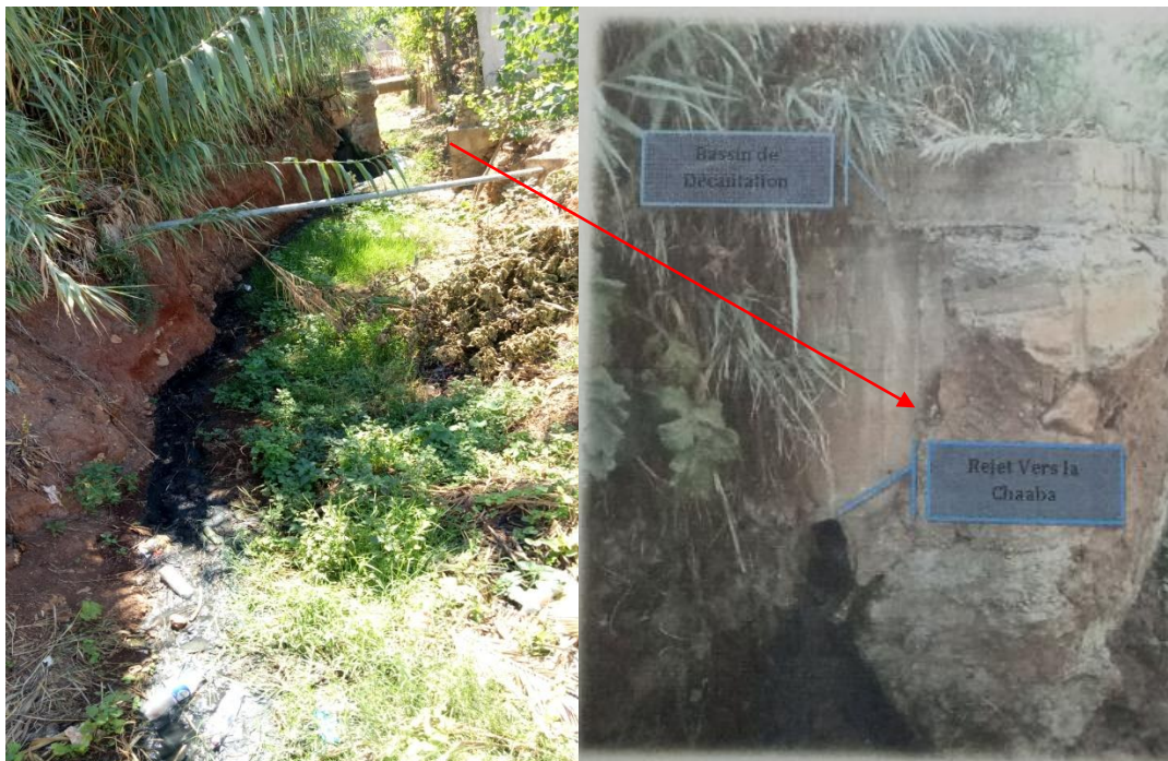
Figure.III.1.Bassin de décantation du sous bassin MahieddineI .
