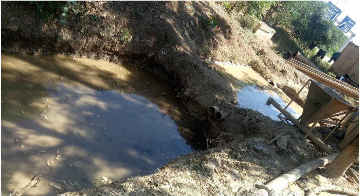
Figure III.2 : Photo du bassin à boue [source ; Khoumeri. M.L & Sahi.A. Chiffa le 15 juin 2020]
