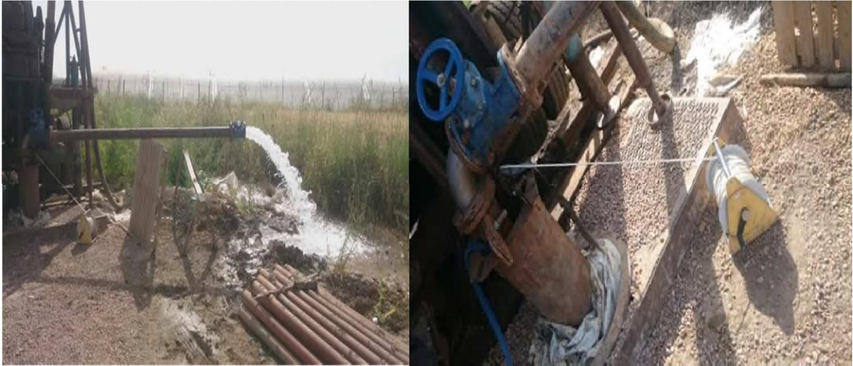
Photo N°14 : Photo montrant le déroulement des essais des pompages au niveau du forage.
