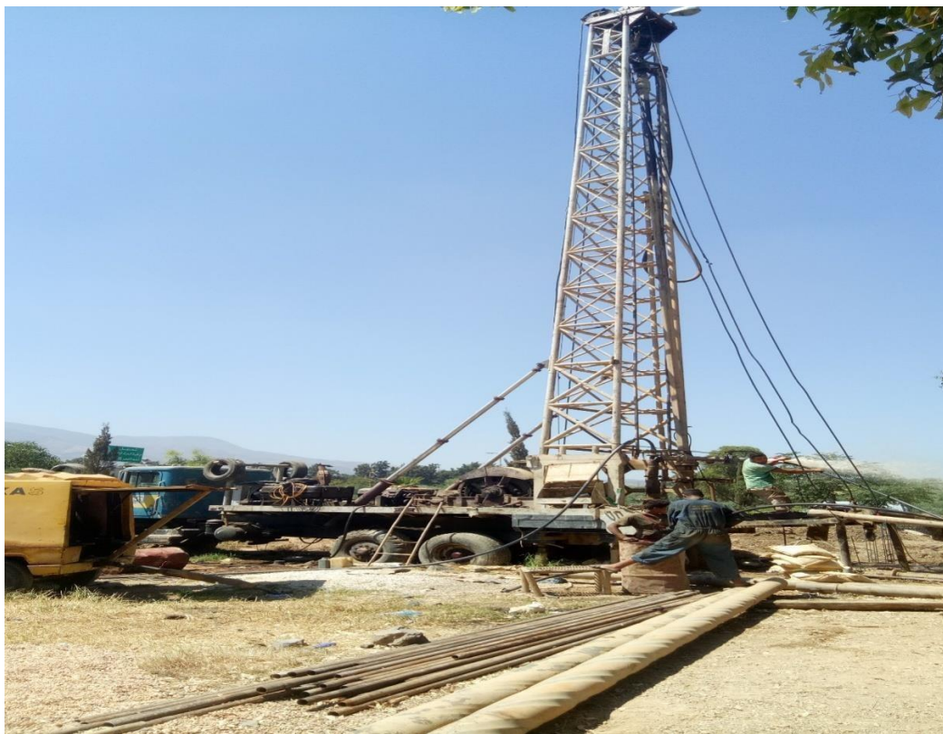
Figure III.5 : Illustration de l'opération de creusement .
