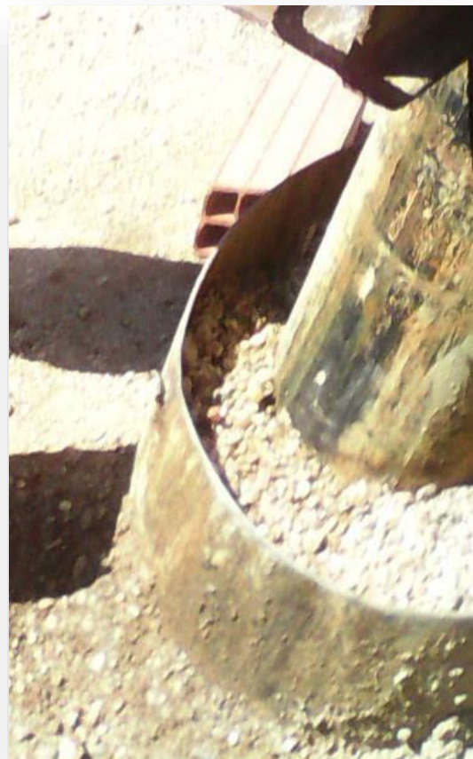
Figure III.12 : Mise en place du massif filtrant. [3]
