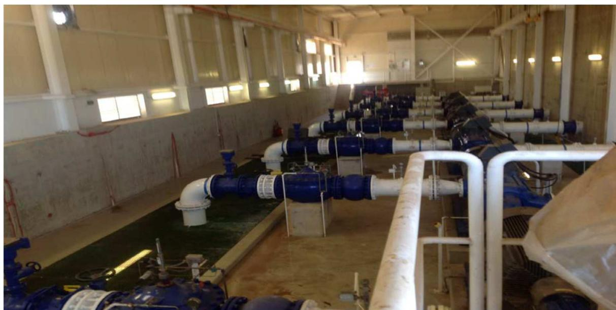
Figure IV-13 : Station de pompage d'eau traitée. (32)
