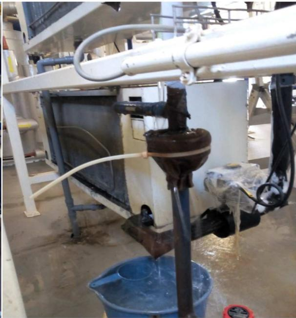
Figure V.03: Fuite dans le système de production de CO2
