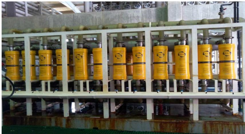
Figure IV.10 : Système de récupération d'énergie. (32)
