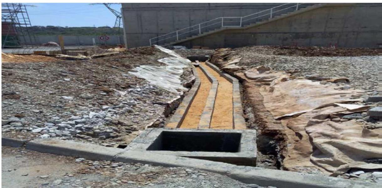
Figure V.04 : La nouvelle conduite d'eau de service.
