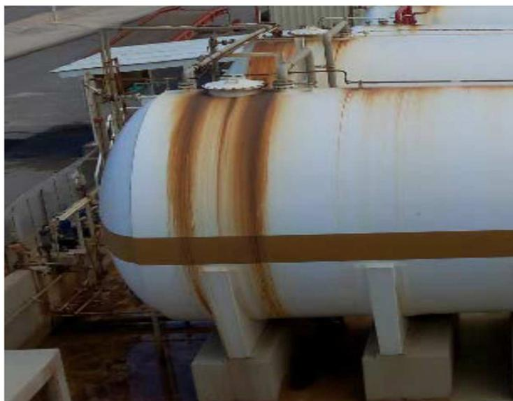
Figure V.01 : Quelque signe de corrosion au sien de la station.
