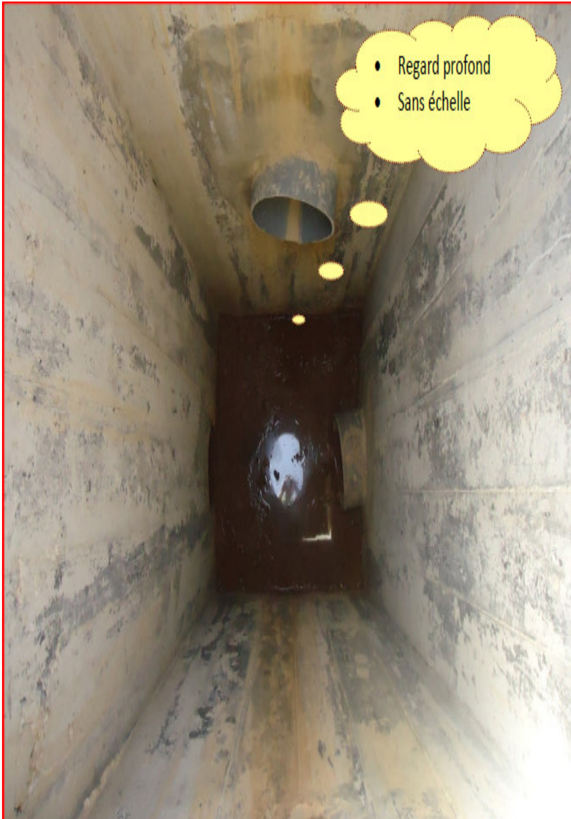
Figure III.3 : Regard profond sans échelle
