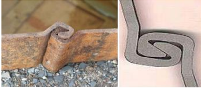
Figure 1-5 Serrure à la jonction de deux palplanches.
