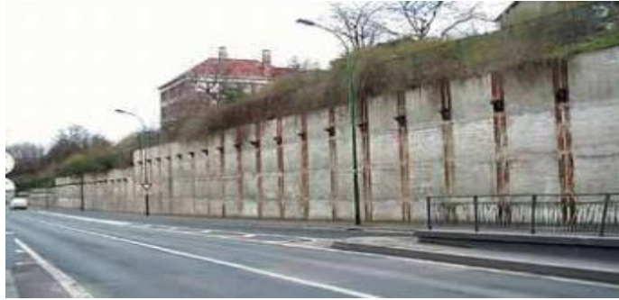
Figure 1-26 Vue générale d'une paroi Berlinoise à Saint-Ouen
