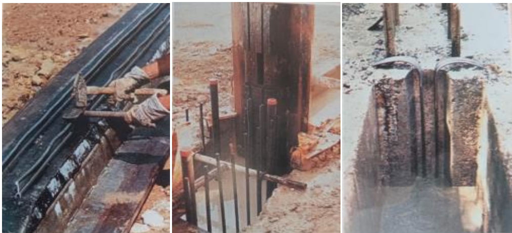
a .Montage des lames water stop dans le coffrage joint b .détail du coffrage avant bétonnage c .empreinte du joint waterstop en place dans le panneau précédent
