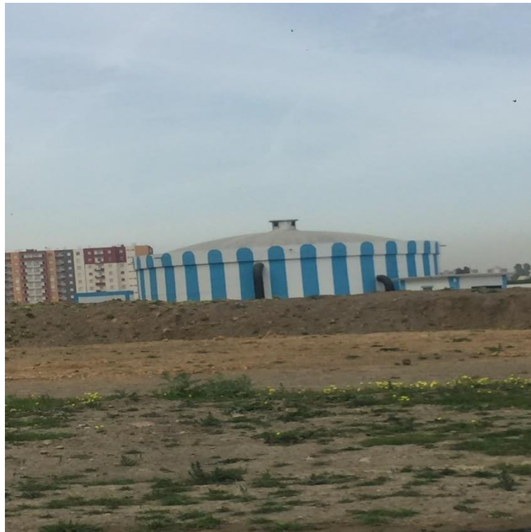
Figure III-2 : Photo illustrant la station de reprise 2 avec une bache RV2000 m 3
