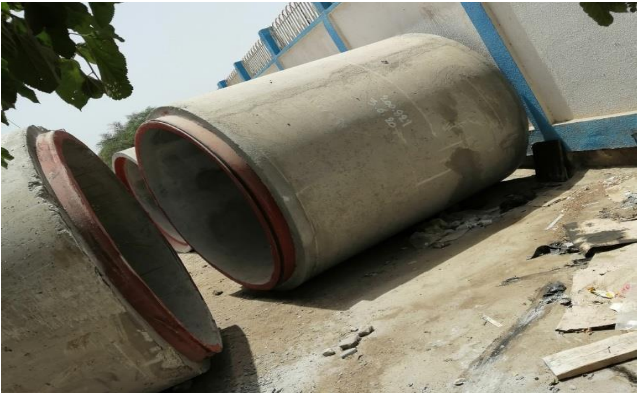
IV.9. Figure photos prise lors du stage sur chantier
