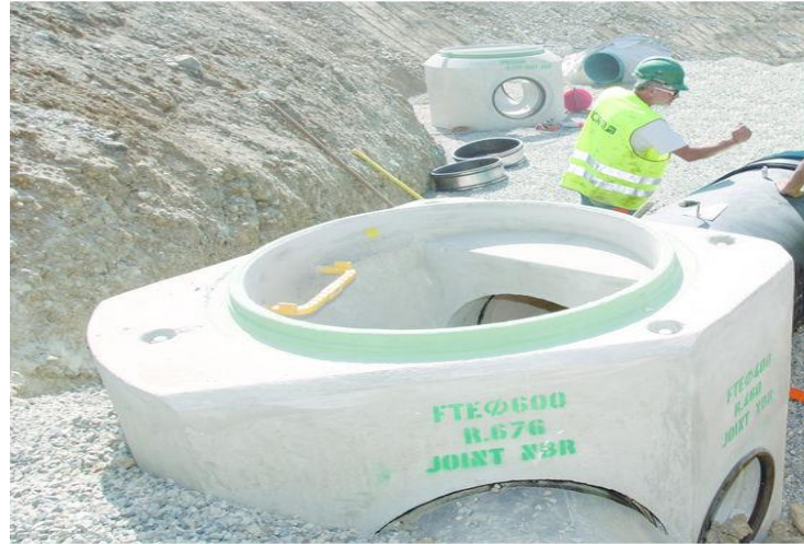
Figure.V12.regard de changement de direction
