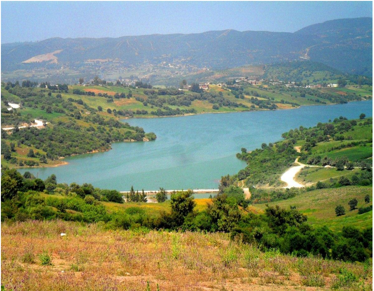
Fig.1.1 photo du barrage keddara (Google image)
