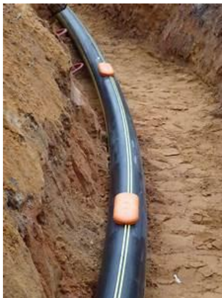
Figure VI.5. Conduite en PEHD (source: Google image)
