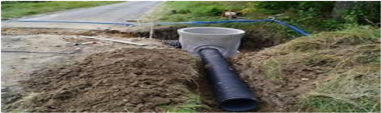
Figure VI.12. Regard de changement de diamètre (source: Google image)
