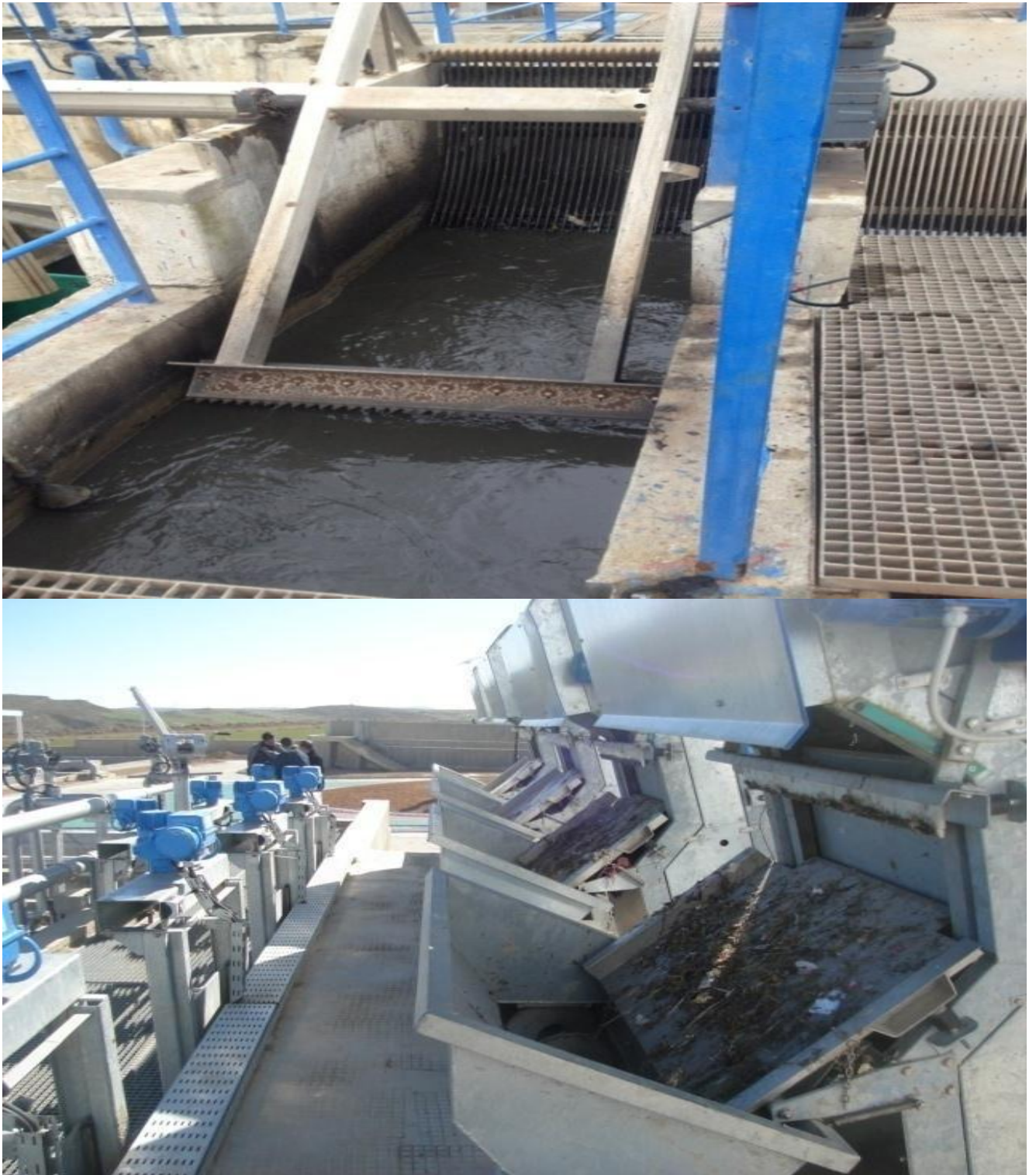
Figure III.3: Dégrilleur automatique
