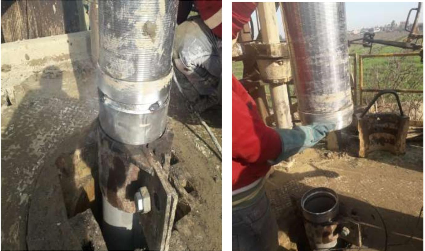
**Photo 15 :** Mise en place du tubage (forage de l'arbaa)
