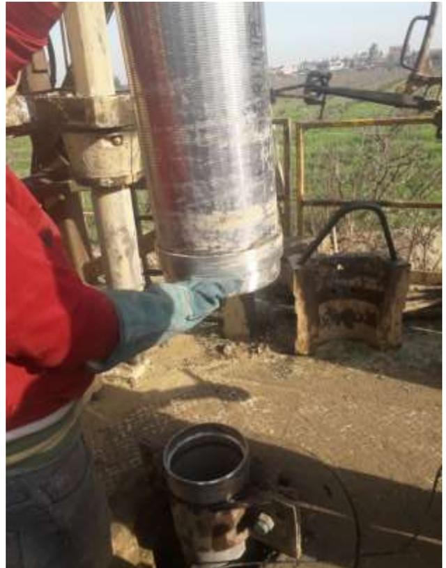
**Photo 23:** Mise en place du tubage (forage de l'arbaa)
