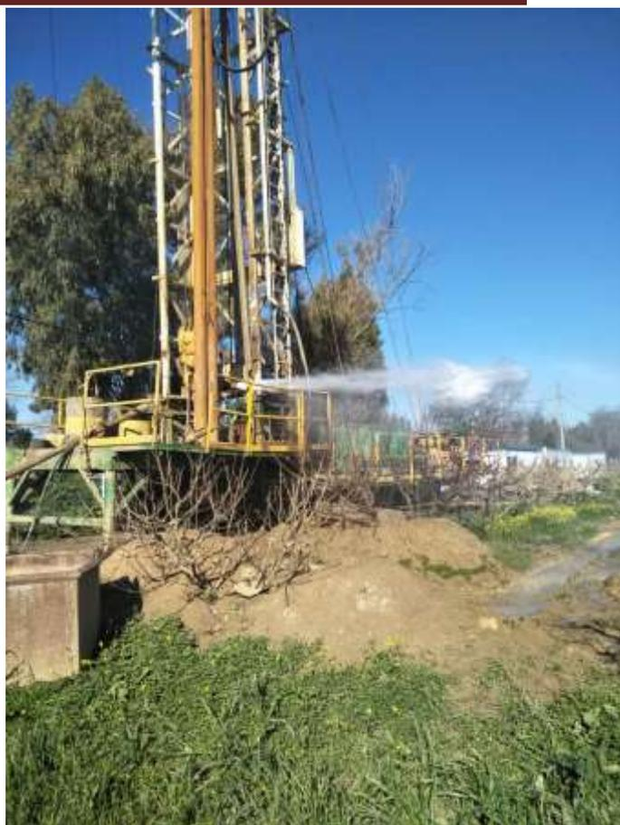
**Photos 24 :** Développement à l'air lift (forage de l'arbaa)
