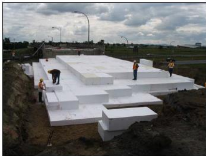
Figure 1 : Construction d'un remblai léger en polystyrène
