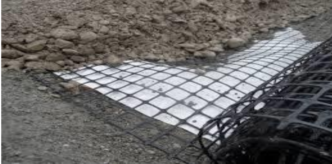
Figure 6 : la mise en place du géogrille
