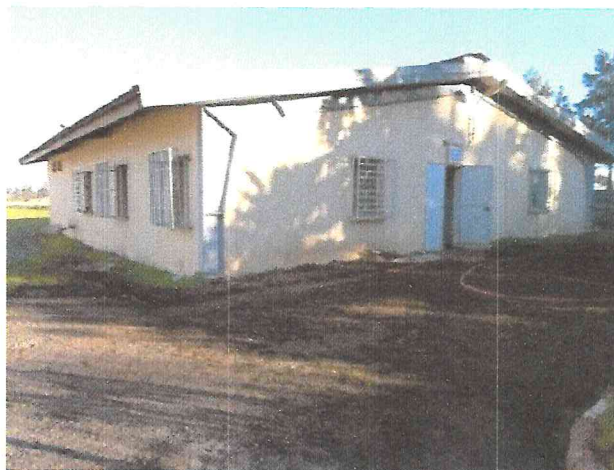
Figure 29 : Bâtiment équin de la station expérimentale de l'Université Blida
