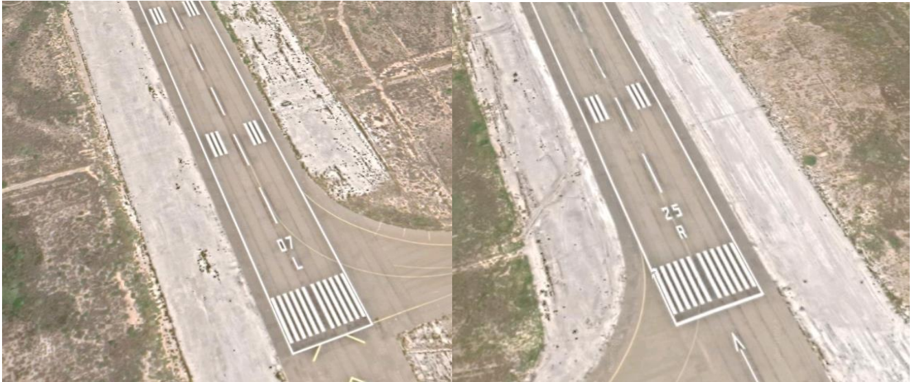
Figure 3.4 : Piste (07L/25R) avec ses accotements non revêtus
