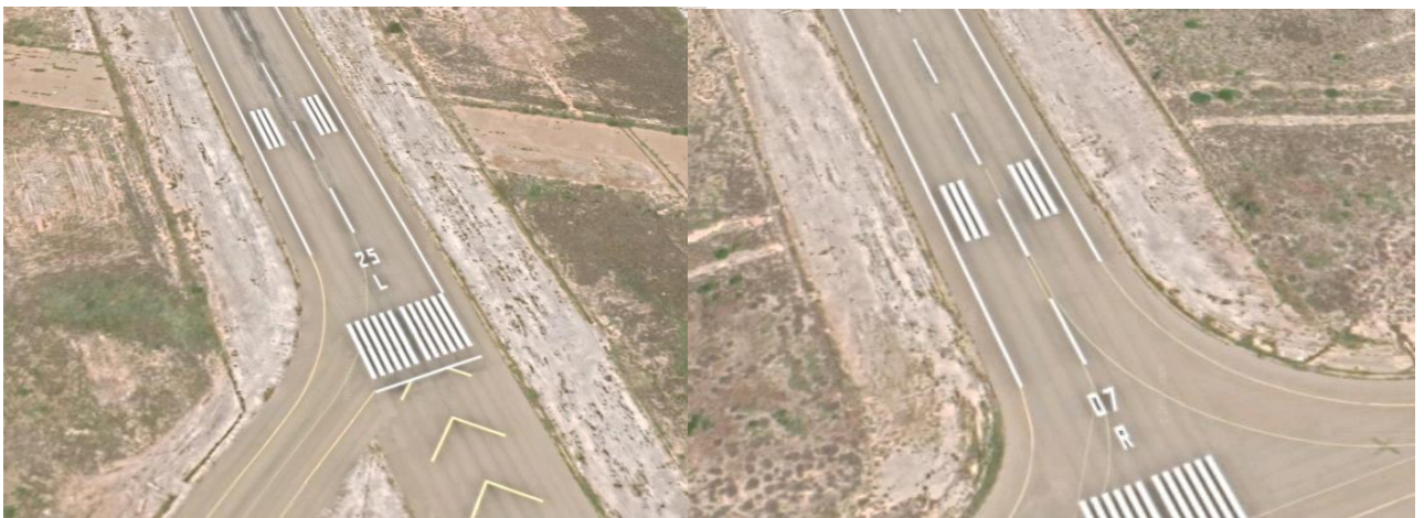
Figure 3.5 : Piste (07R/25L) avec ses accotements non revêtus.
