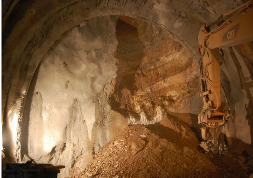
Figure I.3 : creusement à pleine section.
