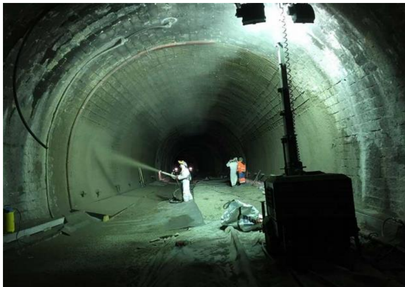
Figure I.20: l'emploi de béton projeté dans un tunnel.
