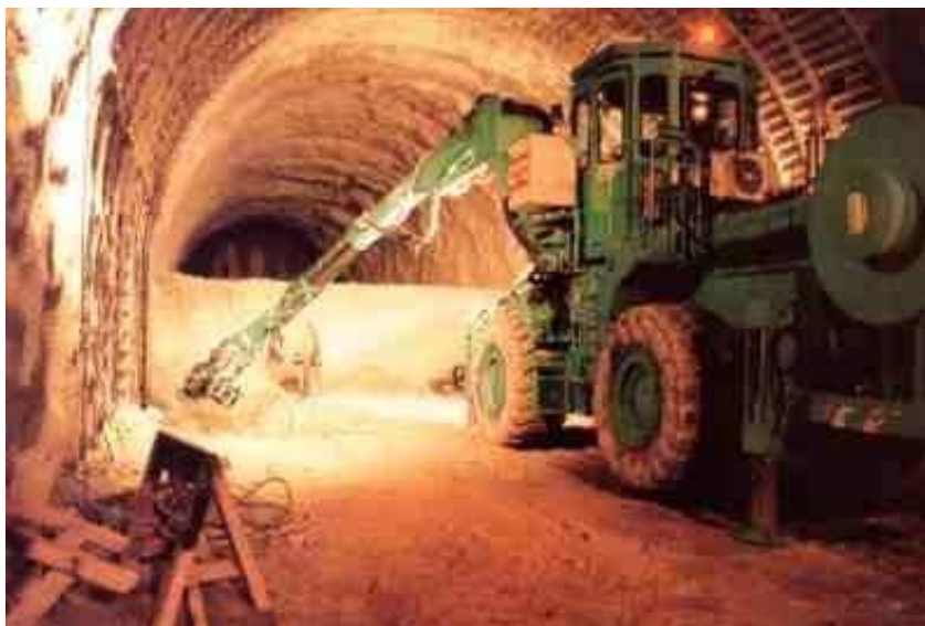
Figure I.4 : creusement par demi-section.
