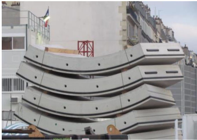
Figure I.21: Exemple des voussoirs en béton.
