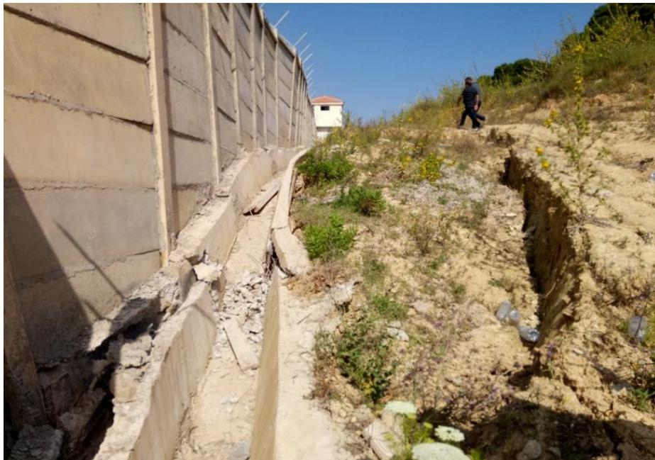
**Figure IV.2 :** Photo montre des fissures sur l'amont du site, 1 mois avant le glissement.
