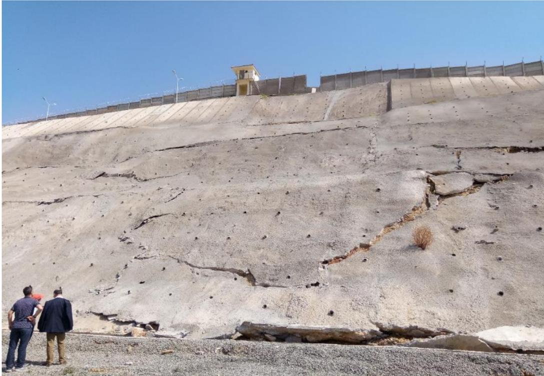
**Figure IV.3 :** Photo montre des fissures sur le soutènement du talus 1 mois avant le glissement.
