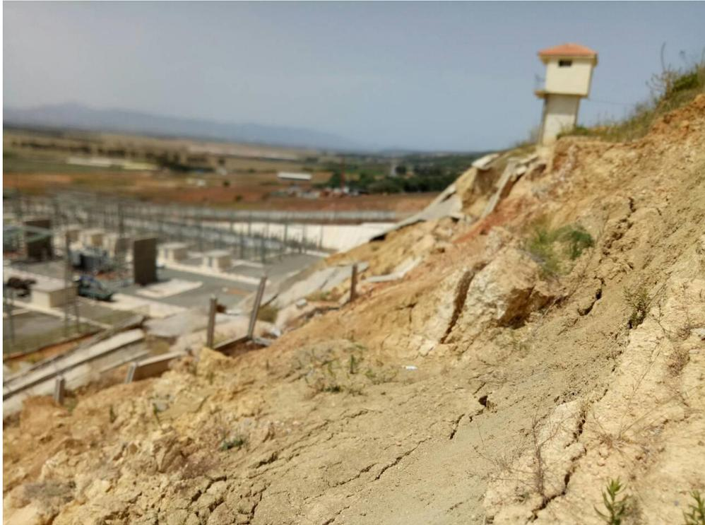
**Figure IV.9 :** Photo montre le risque de renversement de post de surveillance.
