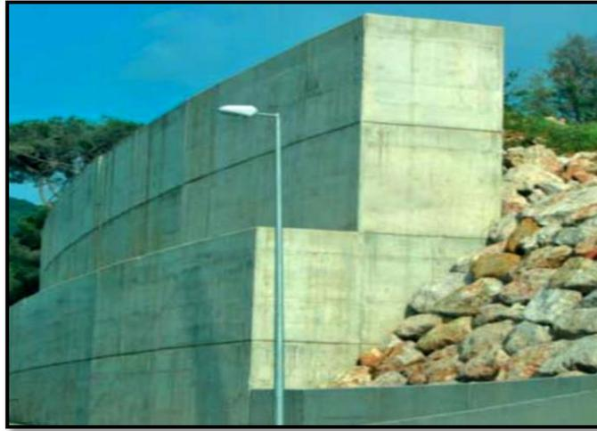
**Figure III.8 :** mur classique en béton armé.
