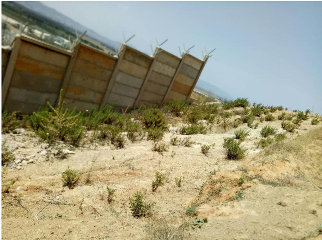
**Figure IV.7 :** Photo montre le risque de renversement de mur.
