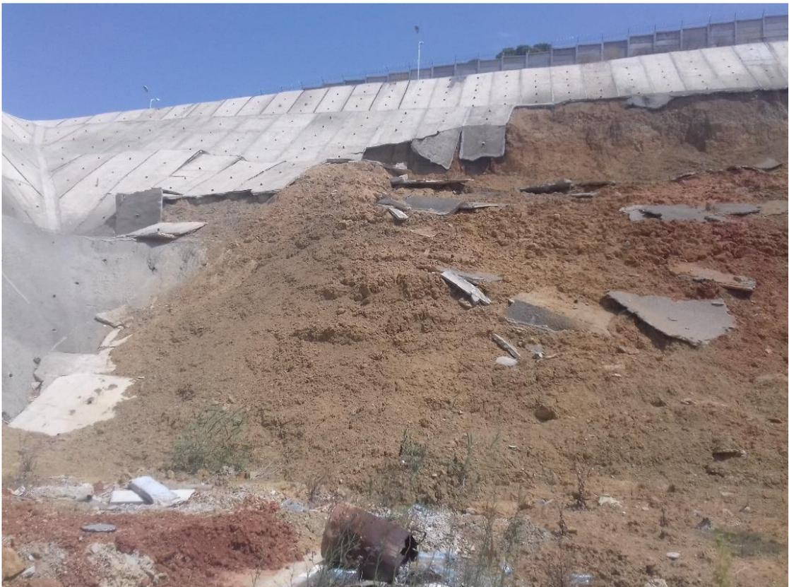
**Figure IV.4 :** Photo montre la ruine totale de soutènement du talus (à cause de glissement)
