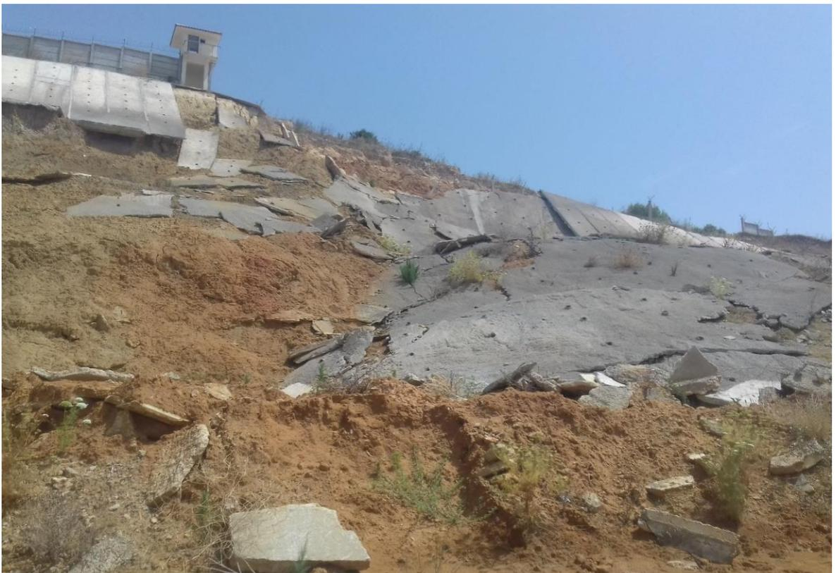
**Figure IV.6 :** Photo montre le risque de renversement de post de surveillance.
