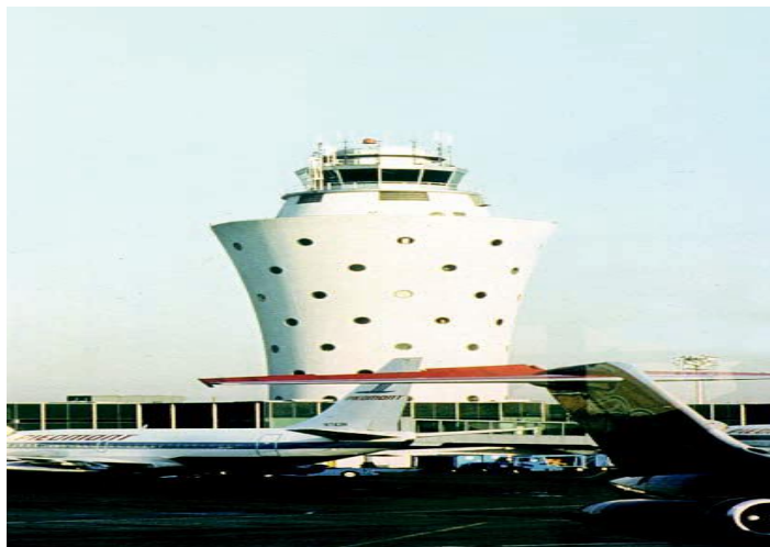
Figure2-3 : vigie servant de couronnement à une tour.
