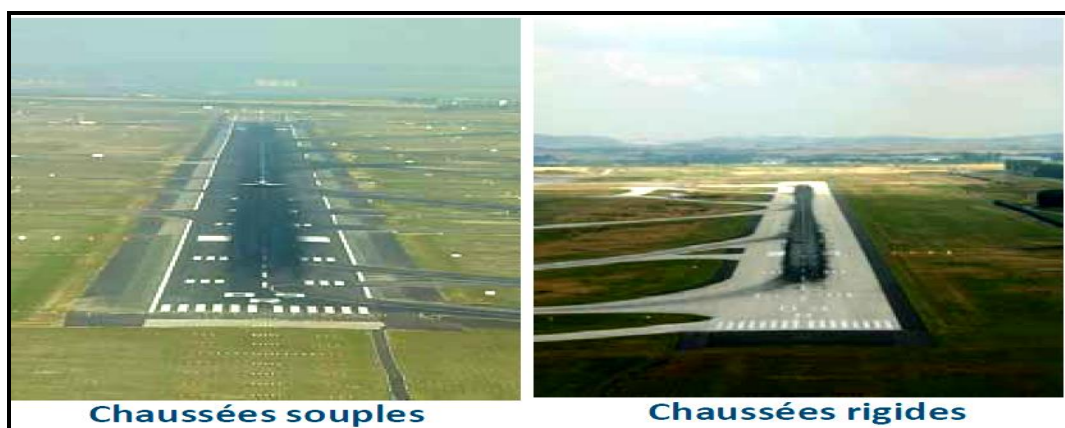
Figure 1-6 : les types de chaussées.
