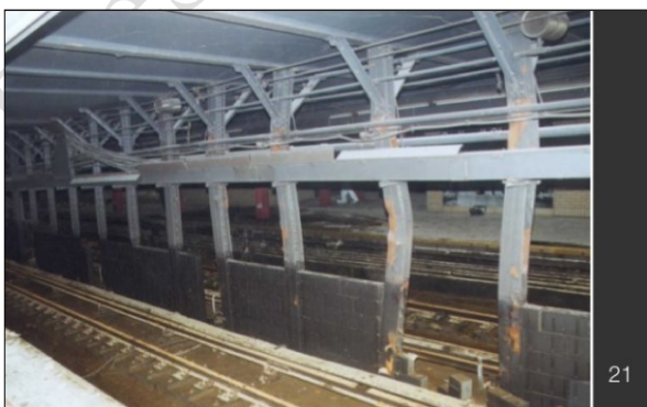
Figure I.9 : Flambement simple des poteaux d'une structure métallique. (8)
