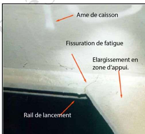
Figure I.46 : Désordres de la fatigue. [2]
