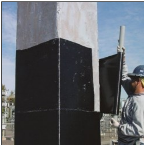
Figure I.63 : Confortement d'un poteau carré élané en BA, par matériaux composite (PRF). (47)
