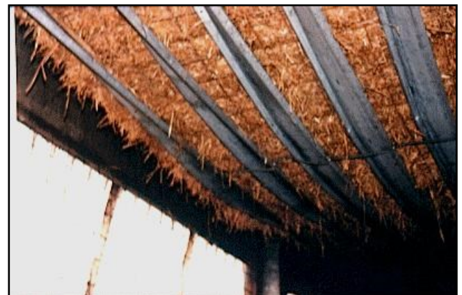
Figure I.14 : Exemple de diversement torsionnel des poutres métalliques. (13)
