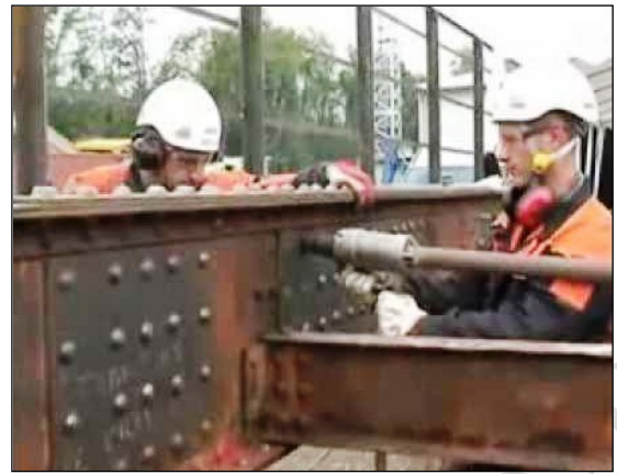
Figure I.45 : Remplacement de rivets défectueux. (34)
