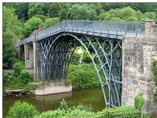
Figure I.1 : En angleterre, 1er grand pont métallique en fonte, 1779. Pont de Coalbrookdale sur la Severn [2]
