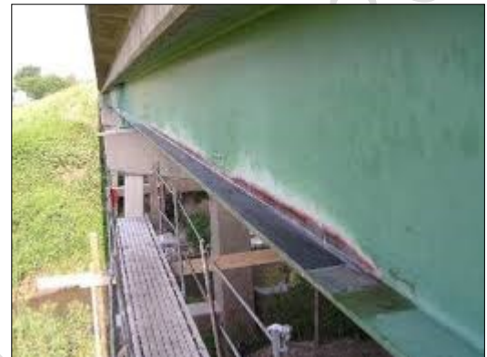
Figures I.71 : Confortement des ailles des profilés métalliques par matériaux composite (PRFC), dans un pont métallique. (55)
