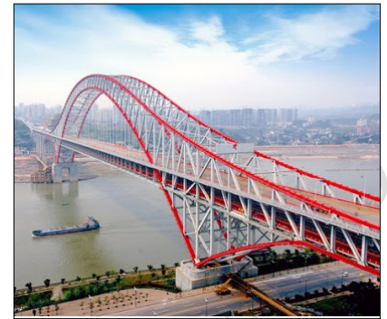
Figure I.7 : Pont à treillis métallique de Chaotianmen-Chine. (6)
