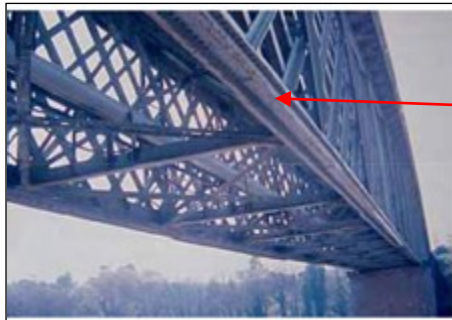
Figure I.42 : Ajout de matière sous la membrane inférieure entre lignes de rivets. [2]
