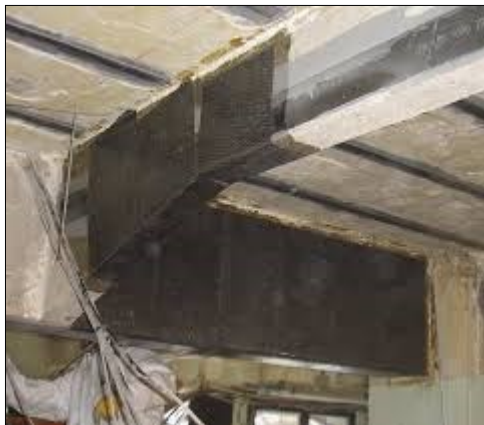
Figures I.72 : Confortement d'une poutre métallique au niveau des jarrets, par matériaux composite (PRFC). (56)
