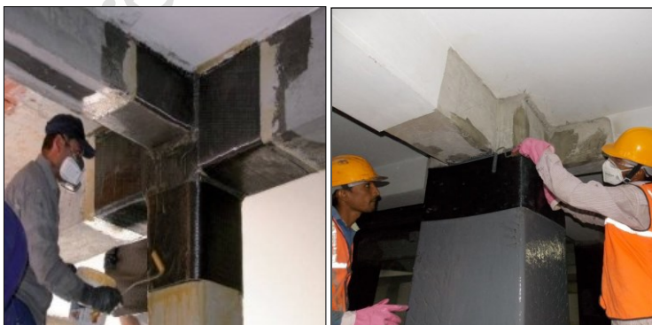
Figure I.65 : Confortement des nœuds en BA, par matériaux composite (PRF). (49)
