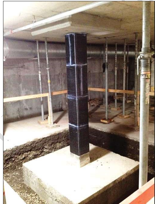
Figure I.64 : Confortement d'un poteau carré en BA, par matériaux composite (PRF). (48)
