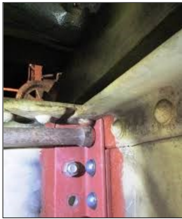
Figure I.44 : Remplacement des rivets défectueux par des boulons HR. (33)
