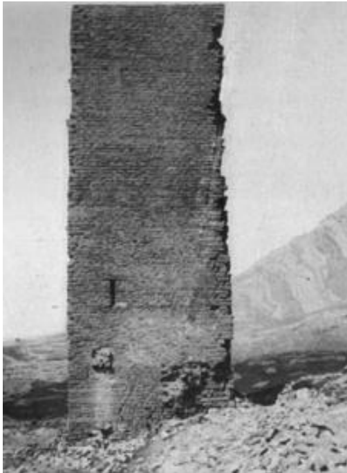
Figure 2.31 Vue en coupe (état dégradé).
