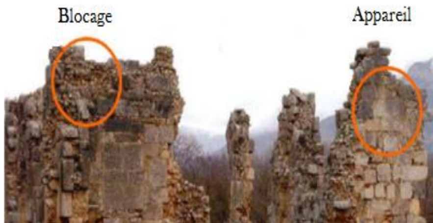
Figure 1.7 Entre la maçonnerie du blocage et la maçonnerie d'appareil.
