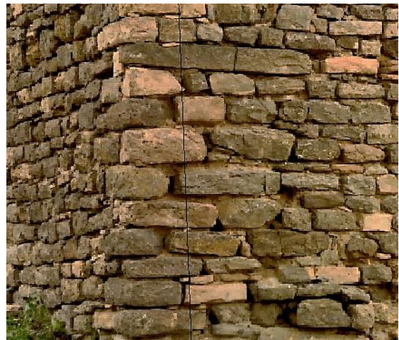
Figure 2.13 Murs appareillés.
