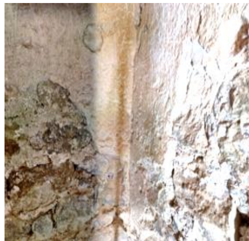
Figure 2.11 Enduit de chaux.
