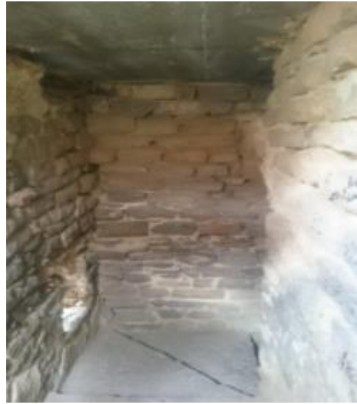
Figure 2.29 Vue au-dessous du plancher. [31]
