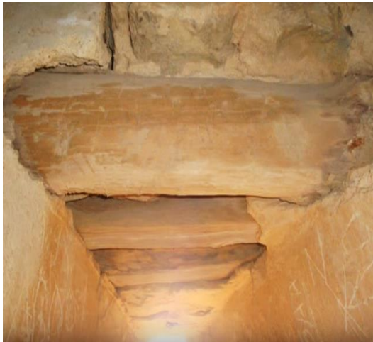
Figure 2.12 Les troncs supportant l'escalier. [31]
