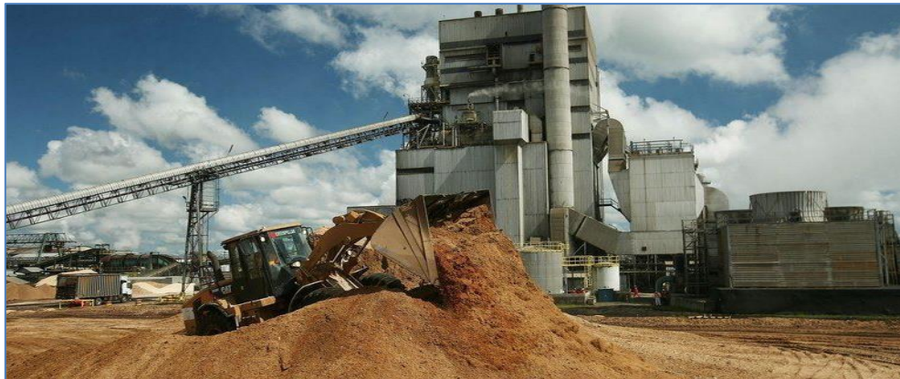
Figure III.5. Centrale de l'énergie biomasse [50].
