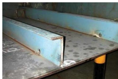
Figure 3.1: Tâches d'huile et de graisse dans un assemble métallique [75]
