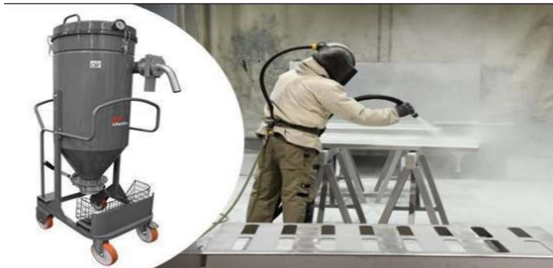
Figure 3.8 : Opération de grenailage en atelier [75]
