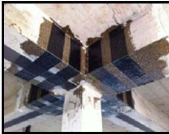
**Figure IV.10** : Une poutre en béton armé renforcée par une lamelle en PRF [20]
