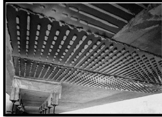
**Figure IV.8 :** Renforcement du viaduc de
