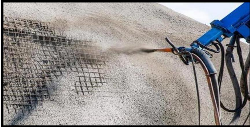
**Figure IV.5 : béton projeté**
