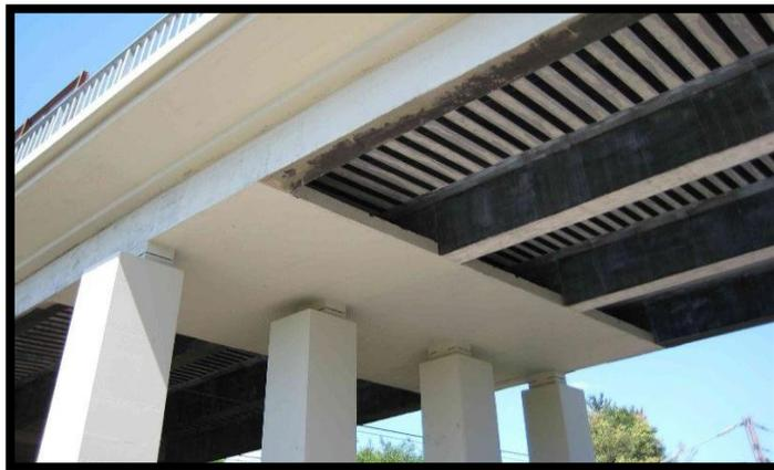
*Figure IV.11 : tablier de pont en BA renforcé par matériaux composites*
