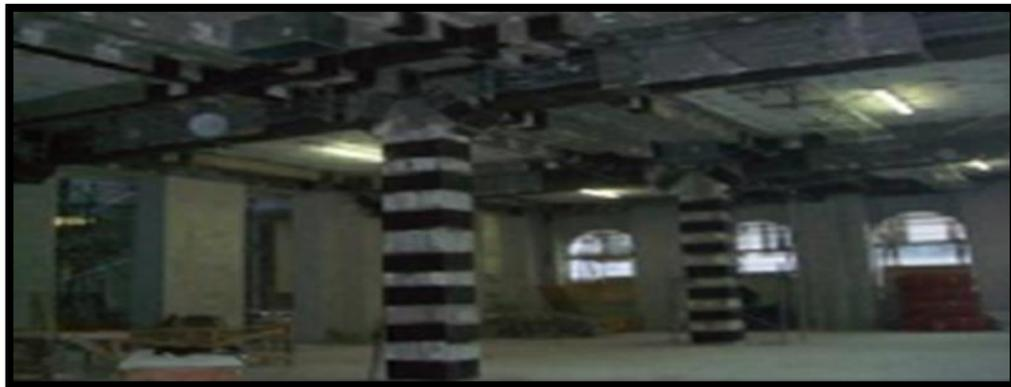
**Figure IV.9 :** Renforcement de structures en BA par matériaux composites
